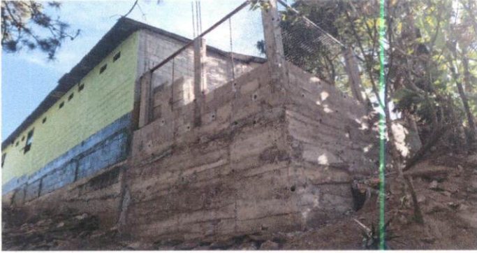
Foto1: Reparación del muro de contención e instalación de malla que se encuentra en el establecimiento
