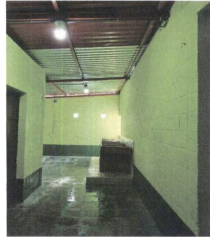
Foto 2: Mejoramiento y ampliación de la cocina que estaba fabricada de adobe.
